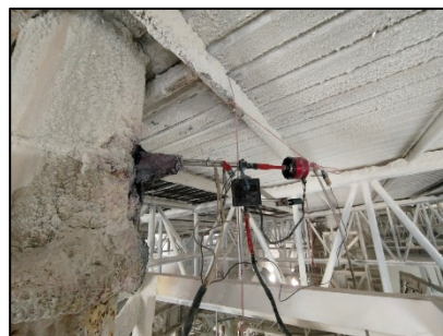
12. ปล่อง Hydrator 3 Wet Scrubber
