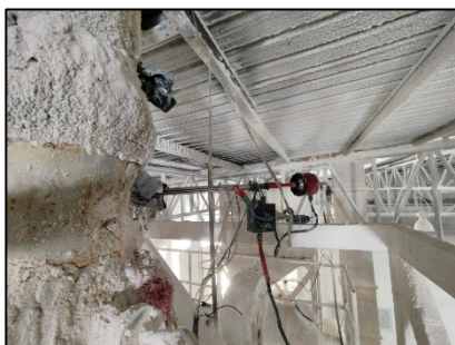
13. ปล่อง Hydrator 4 Wet Scrubber
